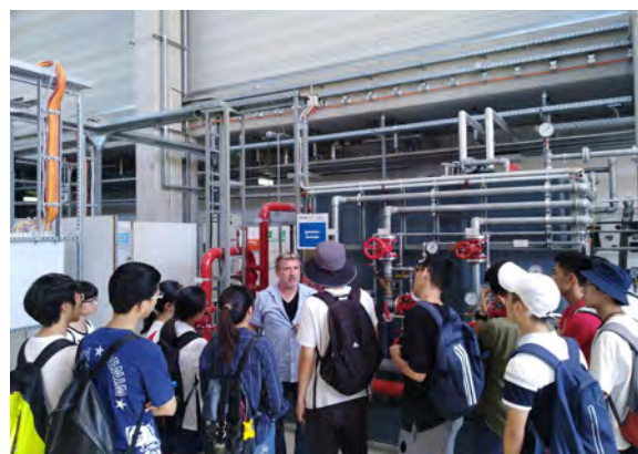
BTU Cottbus-Senftenberg (Cottbus): Prüflabor für sicherheitstechnische Gebäudeausrüstung 科特布斯森夫滕贝格勃兰登堡工业大学 : 安全建筑设备检测实验室
